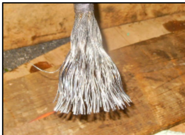
【切り詰められた索条の端部】
