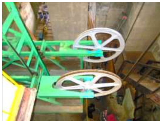
写真④ 平衡索緊張滑車
