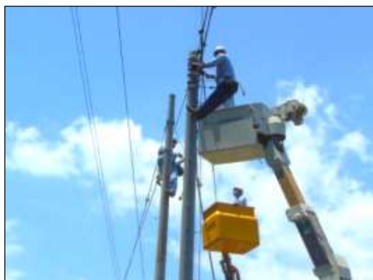
写真 ① 通信線用電柱建替
