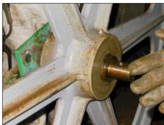
写真⑥ 軸受部交換状況
