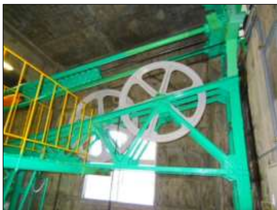
写真③ 平衡索誘導滑車
