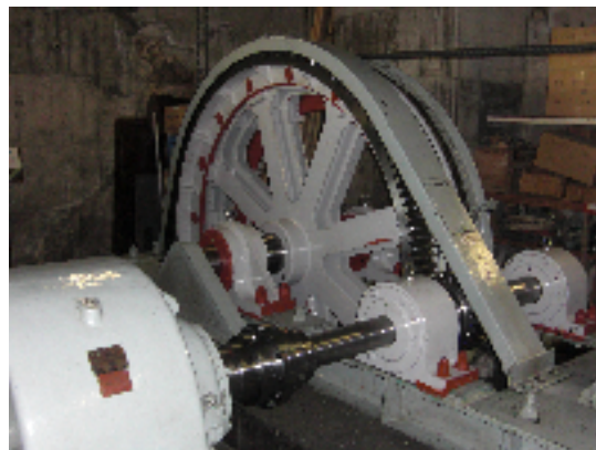
新原動滑車据付
